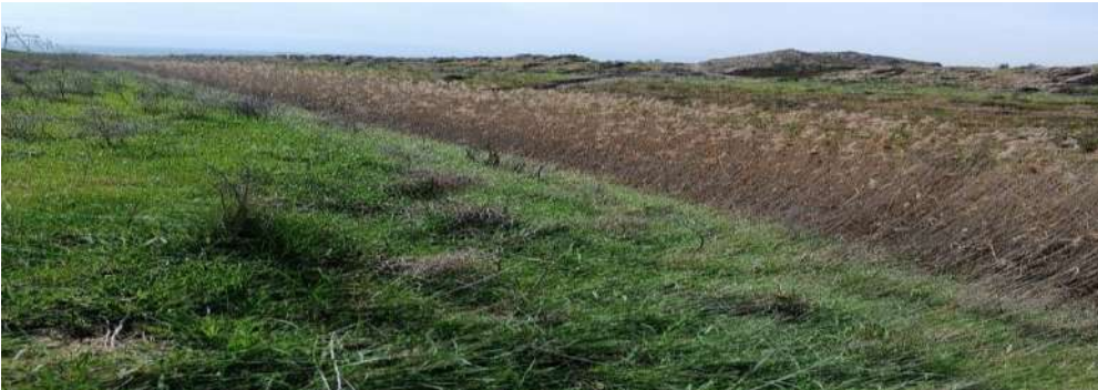
QK- 1 qamışla örtülüb
